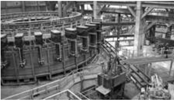
Рисунок 8 — Печь с вращающимся подом в составе автоматизированной линии по изготовлению железнодорожных колес на предприятии Lucchini (Италия) Figure 8 — Rotary hearth furnace as part of the automated line for the railway wheels manufacture at the Lucchini company (Italy)
